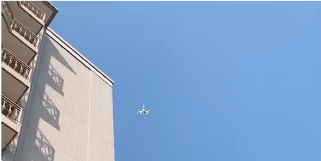
外壁の点検に行くドローン
